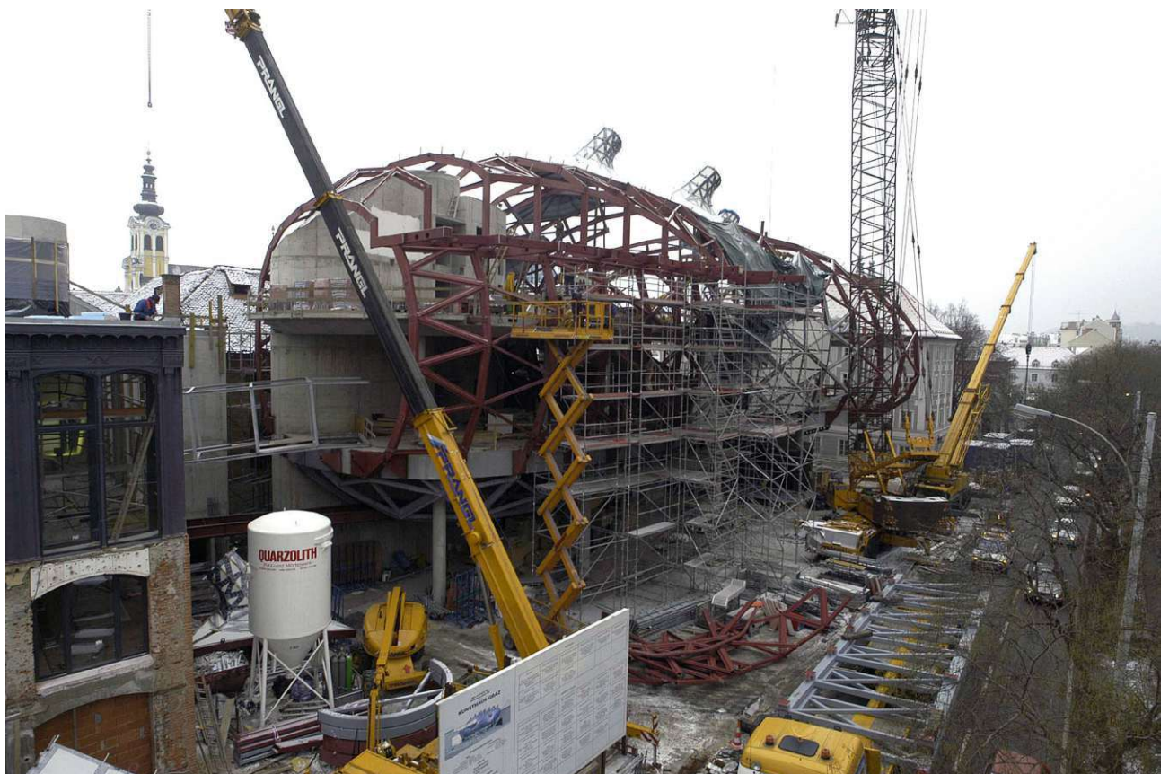
Abbildung 2: Stahlgerüst der Skin Quelle: Harry Schiffer Photodesign
